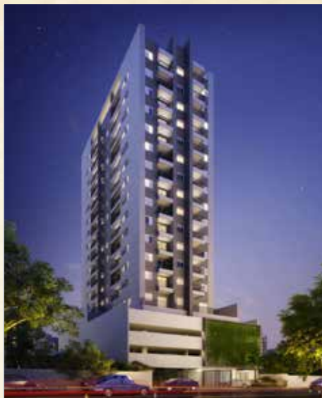
Estação Residencial 153 - Osasco/SP
