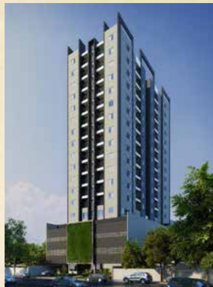
Estação Residencial 163 - Osasco/SP
