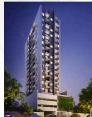
Residencial Estação 153 - Osasco/SP
