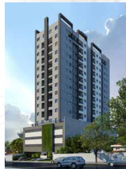
Residencial Estação 348 - Osasco/SP
