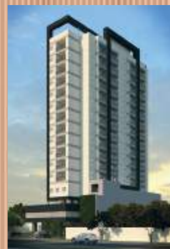
Residencial Estação 235 - Osasco/SP
