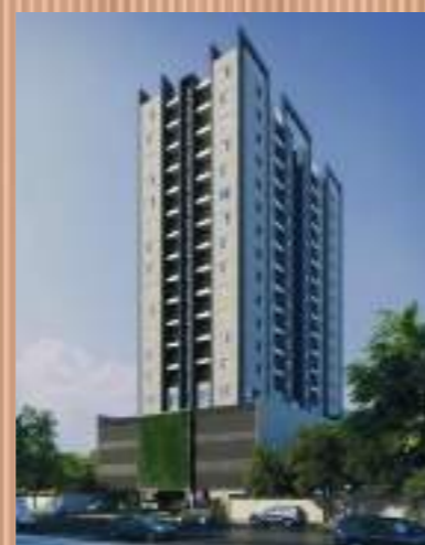
Residencial Estação 163 - Osasco/SP
