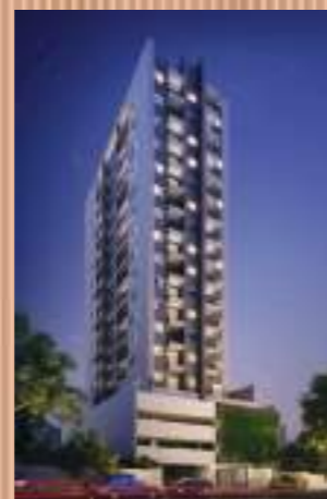
Residencial Estação 153 - Osasco/SP
