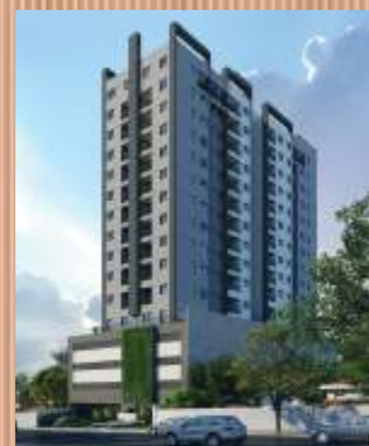
Residencial Estação 348 - Osasco/SP
