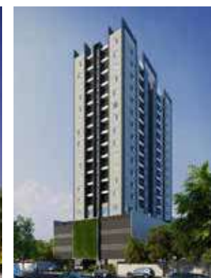
Residencial Estação 163 - Osasco/SP
