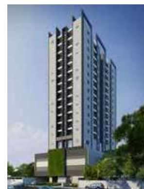
Residencial Estação 135 - Osasco/SP
