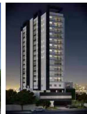
Residencial Estação 235 - Osasco/SP
