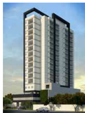
Residencial Estação 084 - Osasco/SP
