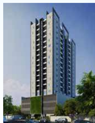
Residencial Estação 163 - Osasco/SP
